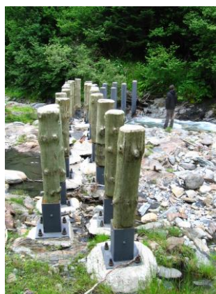
Dispositif dans le lit d'un torrent pour stopper le charriage de matériaux grossiers lors d'une crue (Hautes-Pyrénées)
