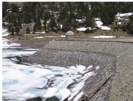
Barrage digue d'Aubert (Hautes-Pyrénées)
