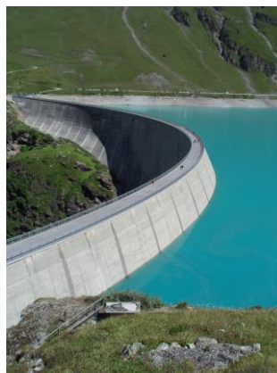
Barrage voûte de Moiry (Suisse)
